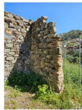
Κατάρρευση τοιχοποιίας και οροφής
